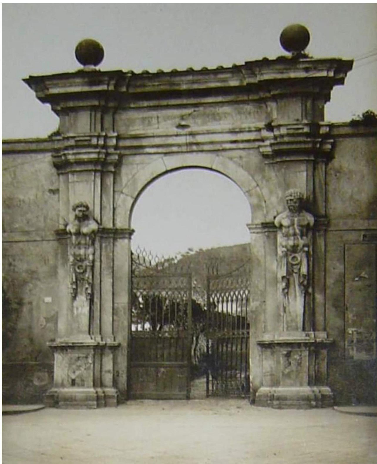
Figura 3.1-11 – Portale di accesso al giardino storico in una foto dei primi decenni del '900. Foto originale presso Accademia BB.AA. di Carrara.
