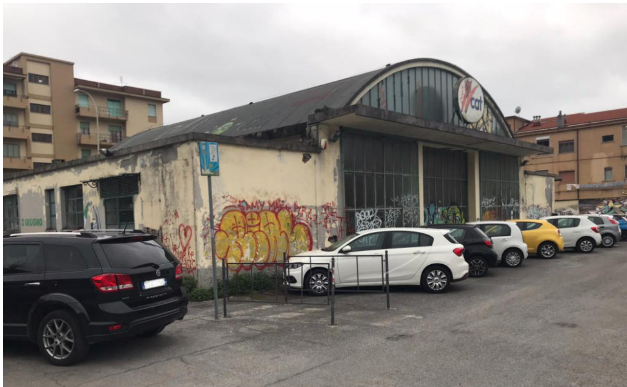
Figura 2.1-7 – Vista dell'edificio "ex-CAT".
