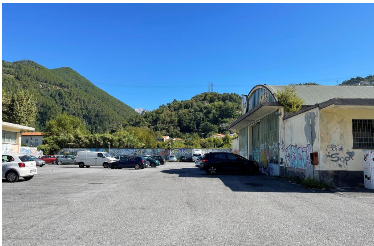
Figura 2.1-9 - Vista interna di parte del lotto in cui è situato l'edificio ex-CAT.
